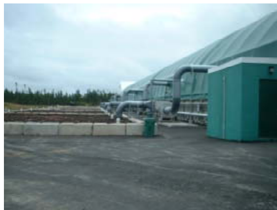
写真8 悪臭除去のためのバイオフィルター装置
