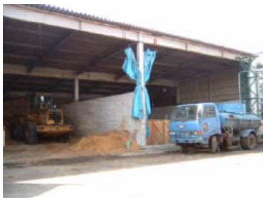
堆肥センターのストックヤード
