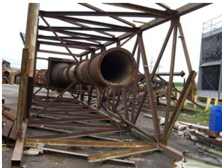
図3-1 解体された焼却炉の煙突 (2007 年視察時撮影、2008 年には撤去されていた)
