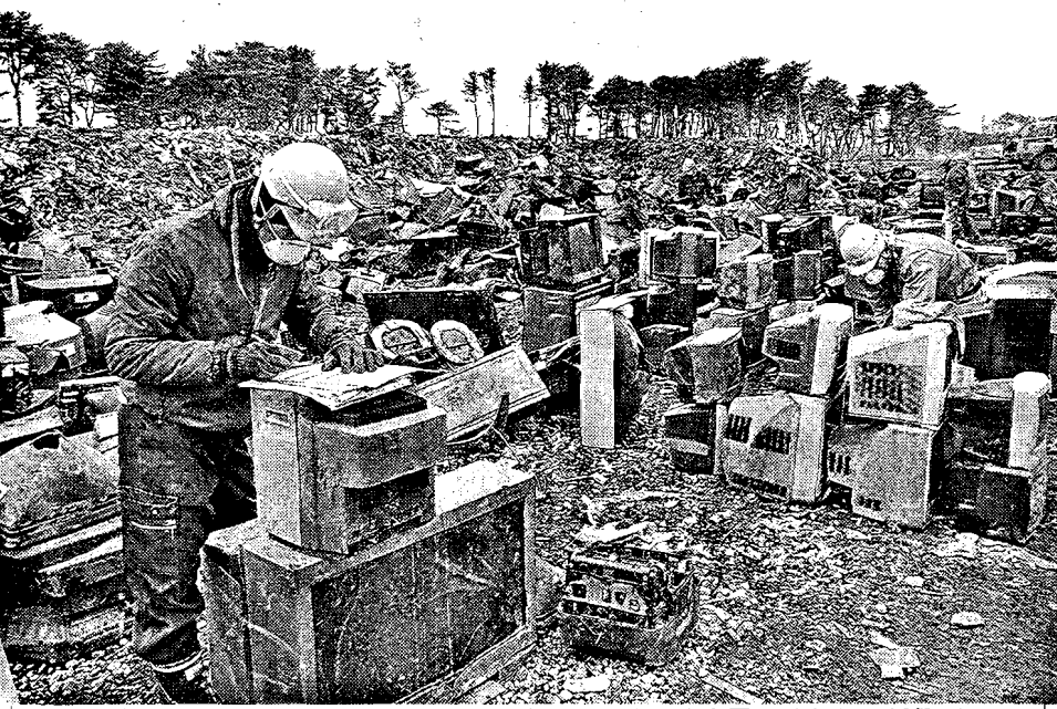
がれき搬入場では、コンクリートくず、木くず、廃家電製品など10種類以上 に分別し、エリア別に保管。作業は地元の業者に委託されている。がれき 発生量の50%以上のリサイクルを目指す＝いずれも14日午後、仙台市で
