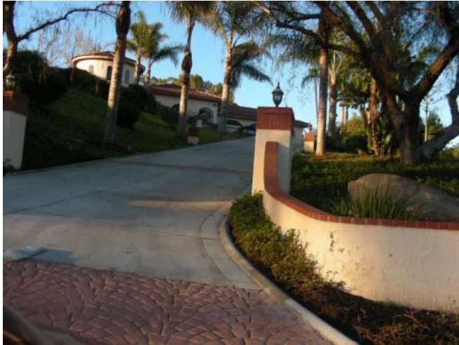
写真 17 ホッジ湖南斜面で焼失を逃れた邸宅
