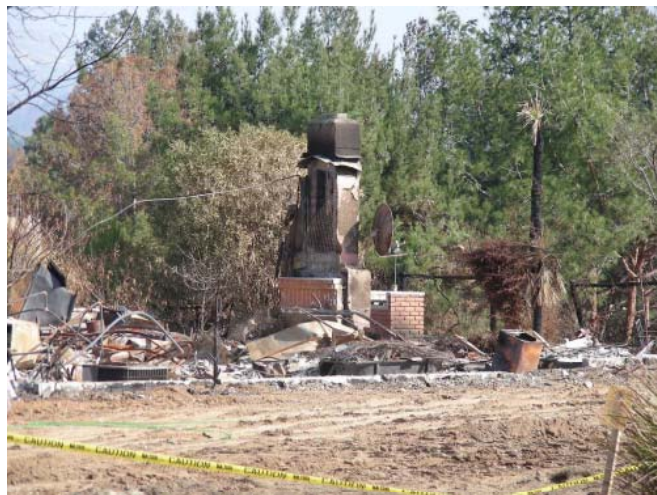
写真 3 全焼した住宅 3
