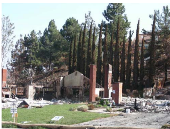
写真 2 全焼した住宅 2
