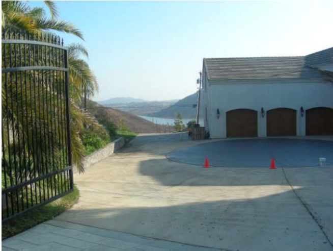
写真 12 ホッジ湖北斜面で焼却を免れた住宅
