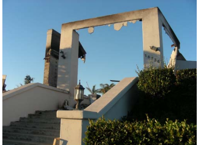
写真 14 ホッジ湖南斜面で全焼した邸宅
