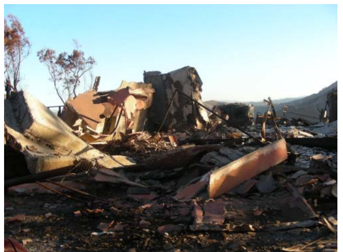
写真 15 ホッジ湖南斜面で全焼した邸宅
