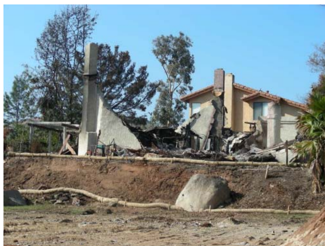
写真 4 全焼した住宅の背後で延焼をまぬがれた住宅。このような例を多く見た
