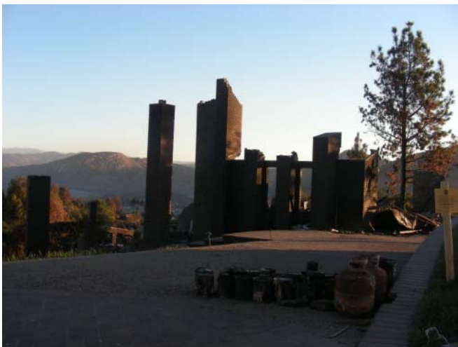
写真 13 ホッジ湖南斜面で全焼した邸宅
