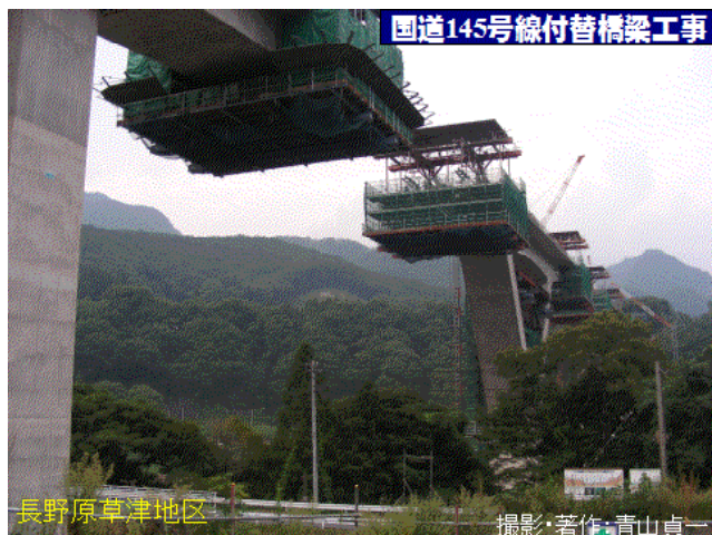
図11 長野原町で日夜繰り広げられる工事
