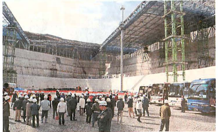
産廃処分場の施工状況を視察する市民ら ＝9日、薩摩川内市川永野町
